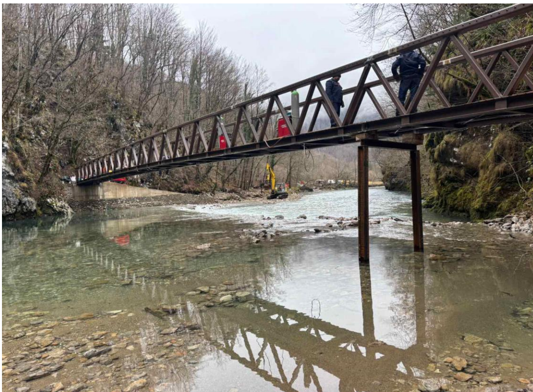
Postavljanje rešetkaste konstrukcije novoga mosta
