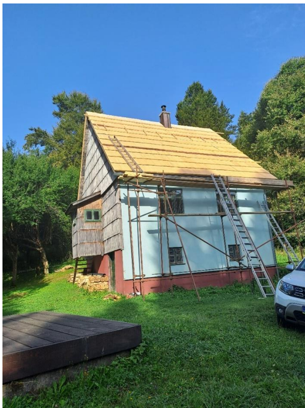
Zamjena krovnog pokrova Agine kuće-dio kulturne baštine crnoluškog kraja
